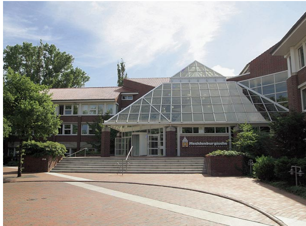
Direktionsgebäude in Hannover
